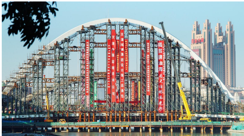
天津大沽桥 4300 吨钢结构防腐 4300 тонн антикоррозионной обработки стальной конструкции моста Тяньцзинь Дагу
