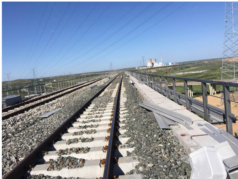
呼准鄂铁路护栏防腐 ЖЕЛЕЗНОДОРОЖНЫЙ ЗАЩИТНЫЙ ПРОЕКТ HUZHUNE АНТИКОРРОЗИОННЫЙ ПРОЕКТ
