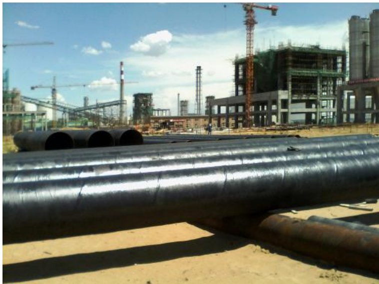
内蒙古久泰能源二期管道防腐 Антикоррозийный трубопровод энергосистемы Long tai во Внутренней Монголии
